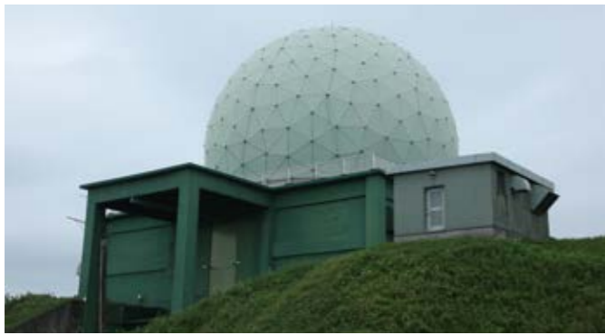
航空自衛隊・当別分屯基地のFPS-3改対空捜索レーダー。レーダーは山の上に設置することで監視範囲を広げることができる(写真:鈴崎利治)
